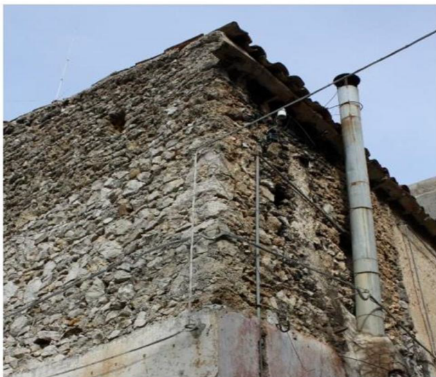
In Figura: Cantonale realizzato con conci di pietra informe
