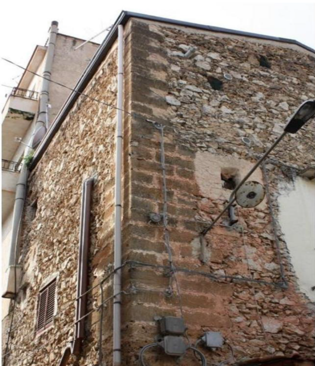
In Figura: Cantonale in conci perfettamente squadrati
